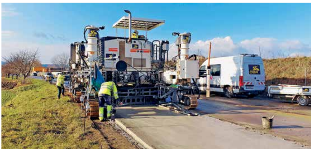
Félpályás „white-topping” betonszönyegezés finiserrel
