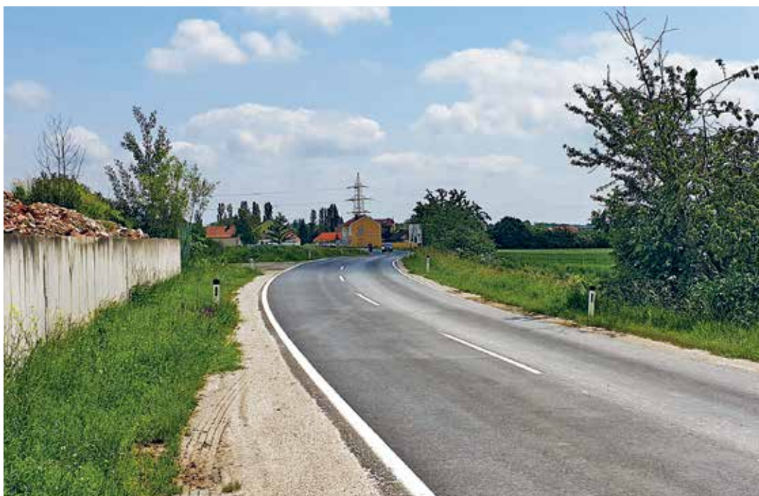
A próbaszakasz az építés megkezdése előtt
