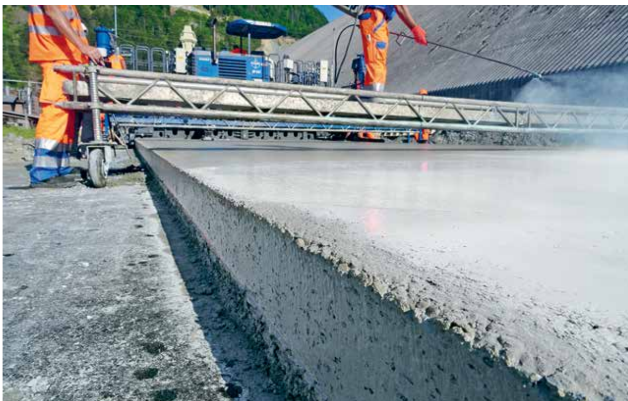
A kötészkeletető- és a párazáró szer (Curing) felszórása a felületre
