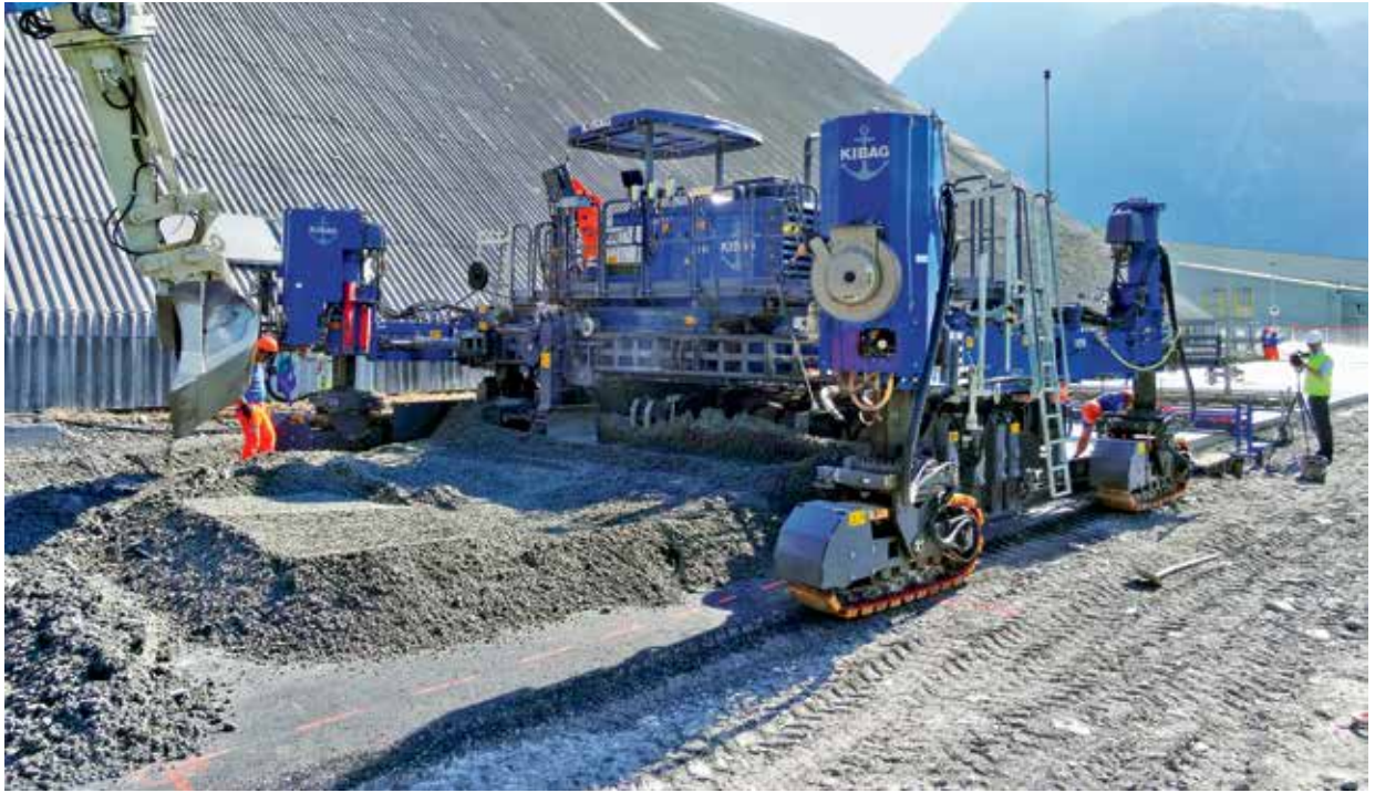
Gépi bedolgozás csúszószalus finiserrel
