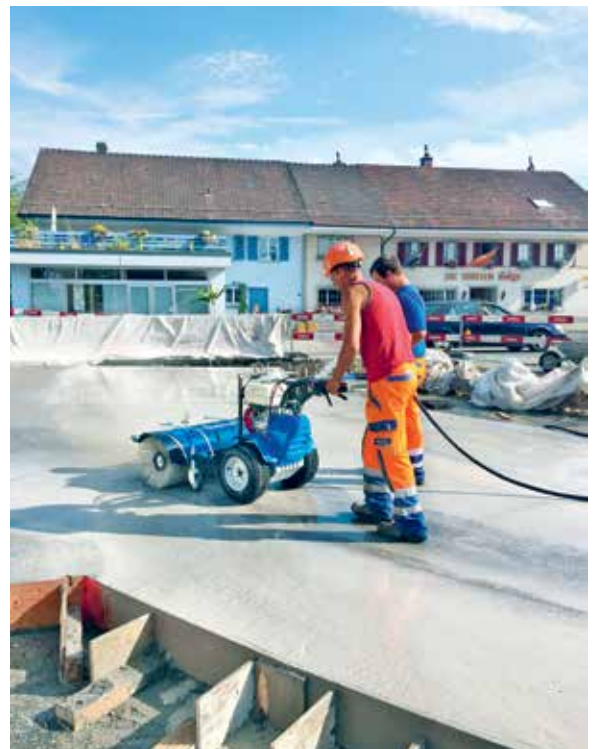
A mosottbeton felület kialakítása a cementpép réteg kikéfélsével
