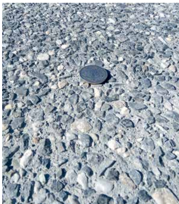
A mosottbeton felület jó tapadású és erősen zajcsökkentő
