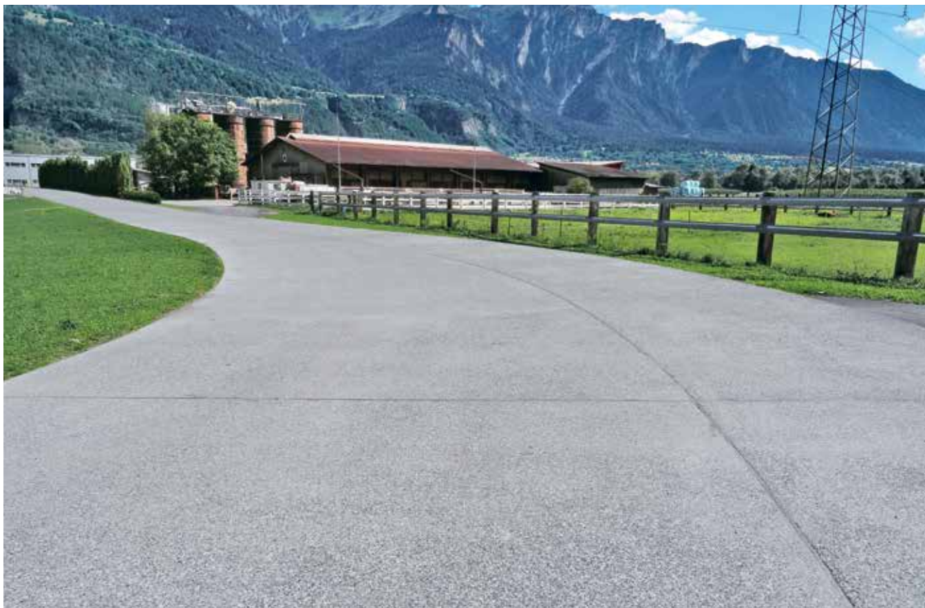
A kész bekötőút látványa a burkolatba utólag bevágott hézagokkal és kitöltésükkel
