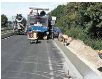
B45 Dreieck Dieburg-Rödermark / Ober-Roden (HE) a padkabeton beépítése és utókezelése
