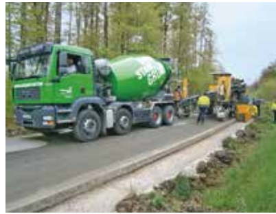
K1209 Büchenbronn (BW) Padkabetonozás offszet csúszószalus finiserrel
