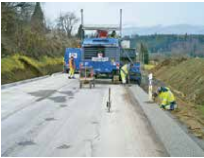
K1021 Merklingen (Weil der Stadt, BW) Finiser és a padkabeton sávok, a vezető-cölöpök beépítése
