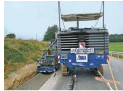
L3098 Schmal Beerbach (HE) Padkabetonba épített teknős folyóka a kész padkabeton sáv mögött
