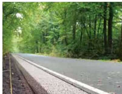
L208 Aumühle-Kuddewörde (SH) A vezetődróttal megépített padkabeton sáv
