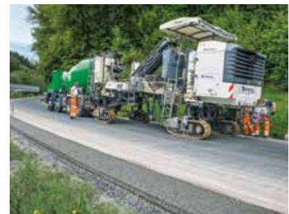
B460 Hüttenthal-Marbach (HE) Egy második padkabeton sáv beépítése offszet csúszószalus finiserrel
