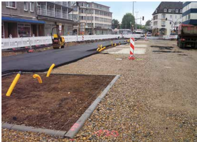
4. ábra: A fagyvédő-réteg/teherhordó kavicsréteg, mint építési tükör
