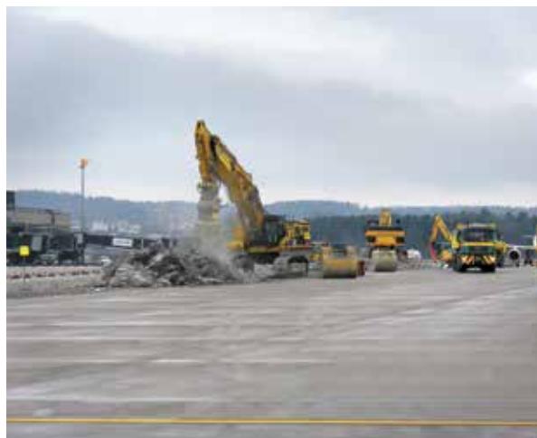
A meglévő betonburkolat feltörése
