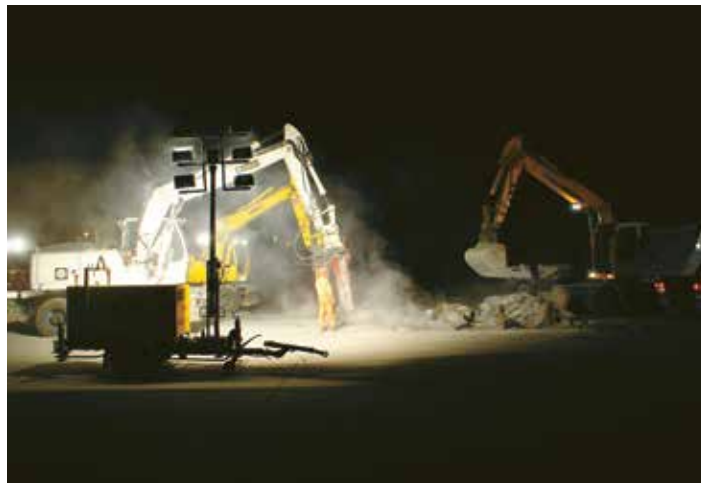
Éjszakai üzemszünet alatti burkolatfeltörés
