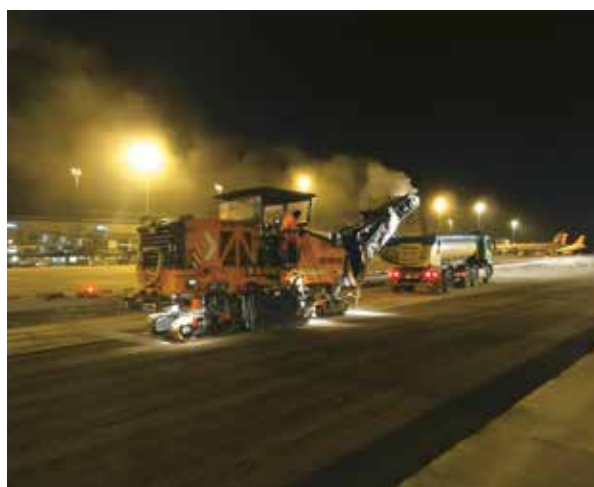
A cementstabilizációs alsó réteg bemarása
