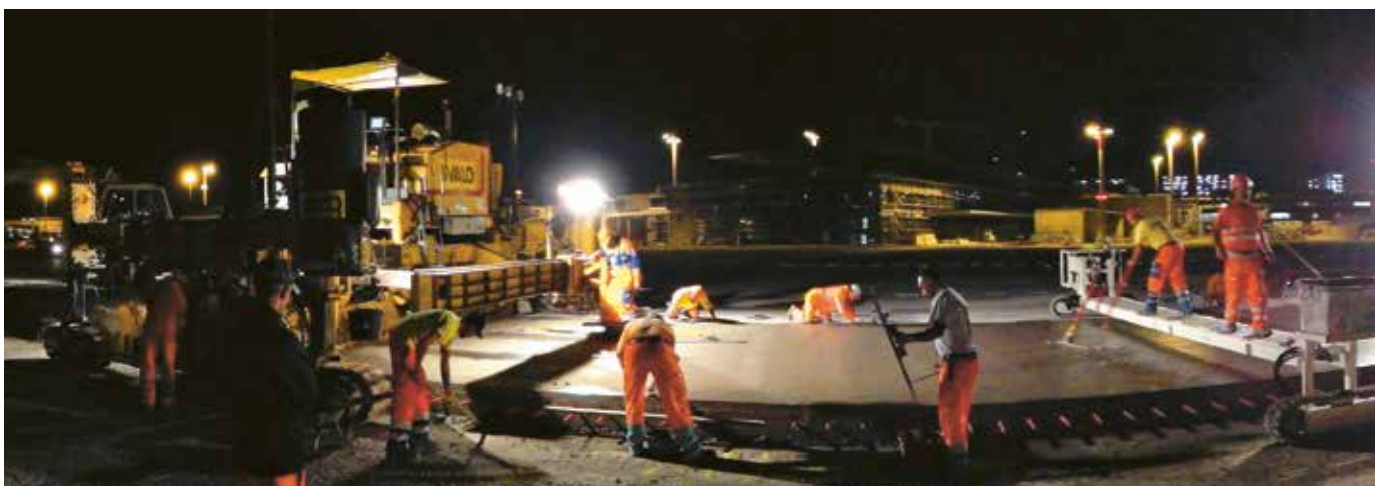
Gépi betonbedolgozás csúszózsálús finiszerrel
