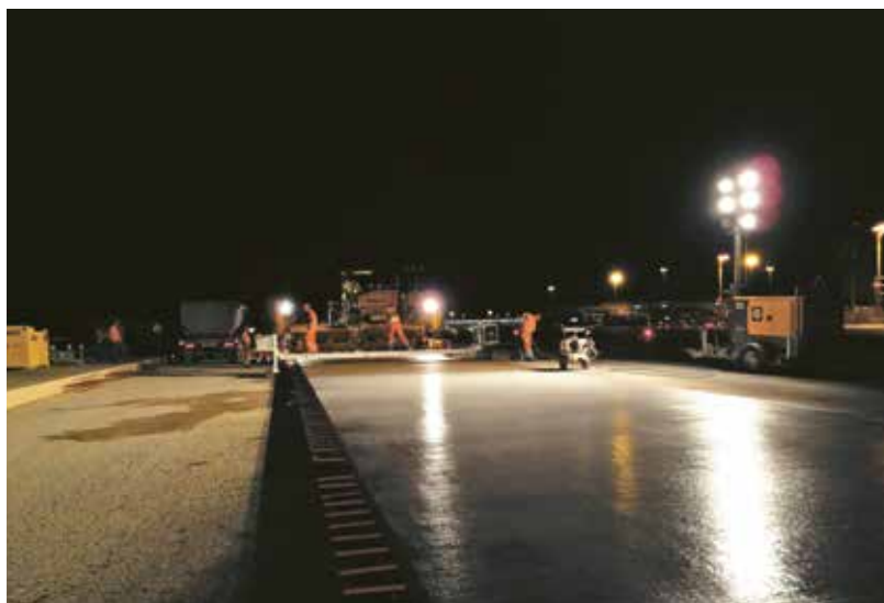
Gépi betonbedolgozás csúszózsálas finiserrel
