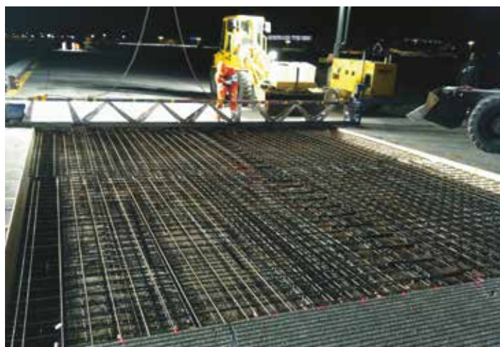
A gyorsbeton lemez számára elhelyezett hálósasalás
