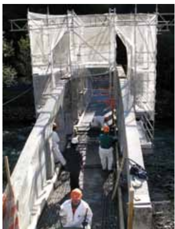
Egy többfunkciós UTSzB réteg beépítése (erősítés, szigetelés, pályalemez burkolat)
