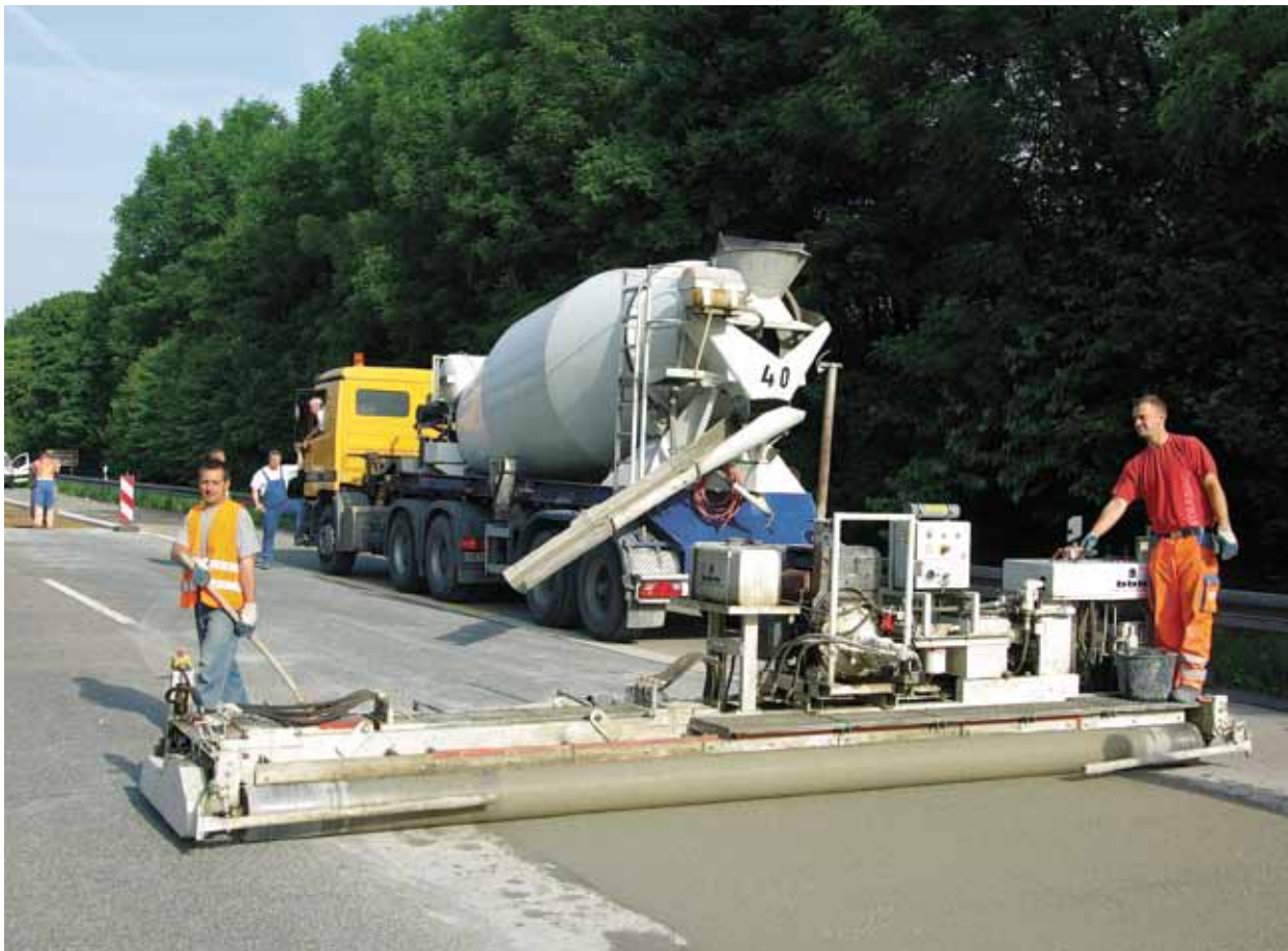
2. ábra Építésjellelű fenntartási munka betonpályán: lemezcseré
