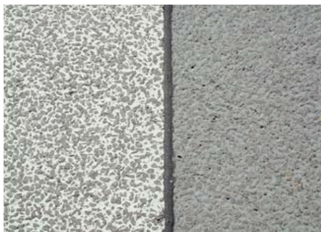
Kész HD, a sötét és világos burkolat elválasztása aszfalthézaggal
