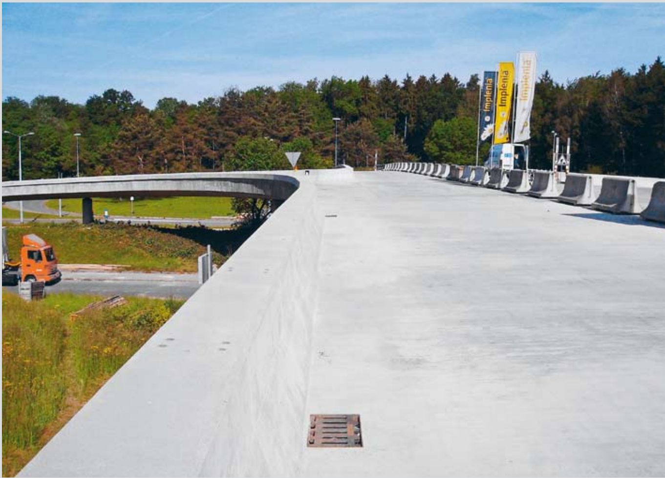
Az Einstein-híd új betonburkolata az előtétbeton szegéllyel
