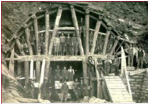
Az első Gotthard vasúti alagút építése
