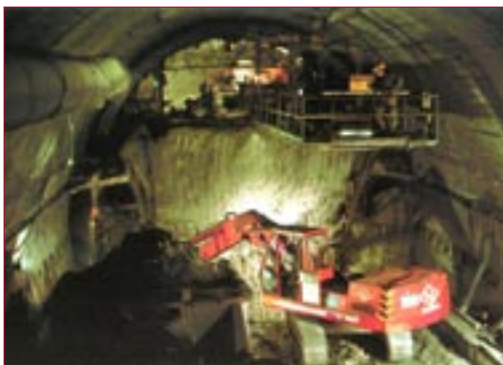
A Gotthard közúti alagút építése
