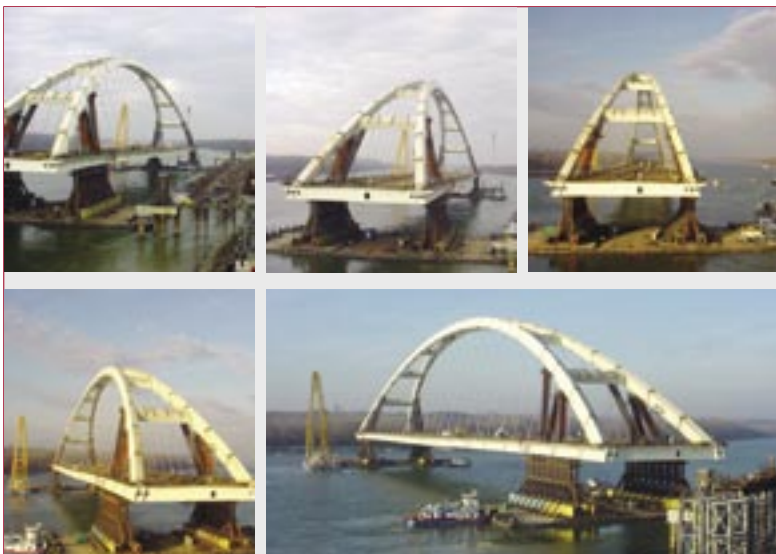
A 90 fokkal elfordított végleges pillérekhez úsztatás folyamata
