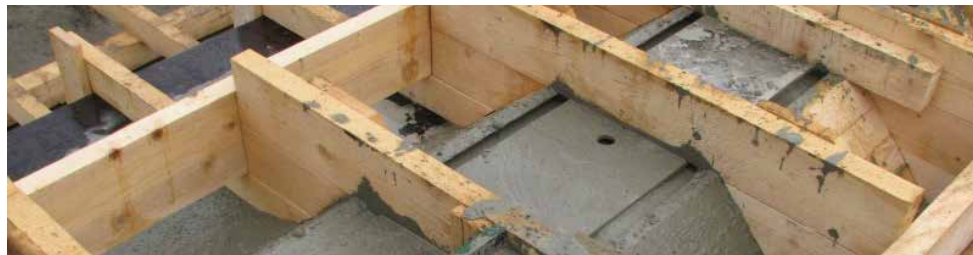
4.6.7. ábra: Szimmetrikus próbazsalu betonozó nyílással
