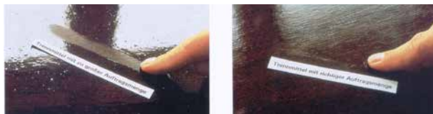
1.4.7. ábra: A formaleválasztók felhordási mennyiségének ellenőrzése ujjpróbával (Forrás: Sika Beton Kézikönyv)
