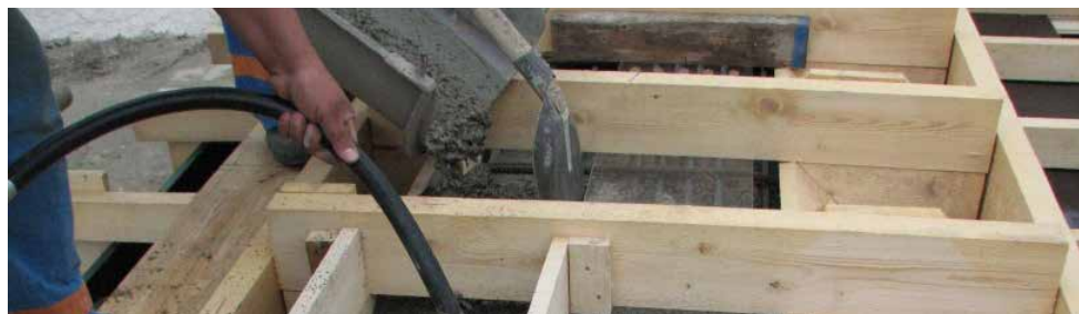
4.6.6. ábra: Aszimmetrikus próbazsalu betonozó sávval
