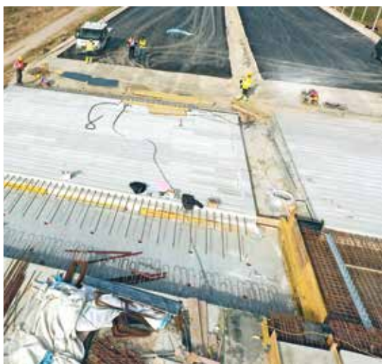
A pályaatmenet műszaki részletei: a beton csúszólemezen fekvő előregyártott elemek veszik fel a mozgásokat. Jobbra fent: A Satzengraben híd építés alatti madártávlati képe.
