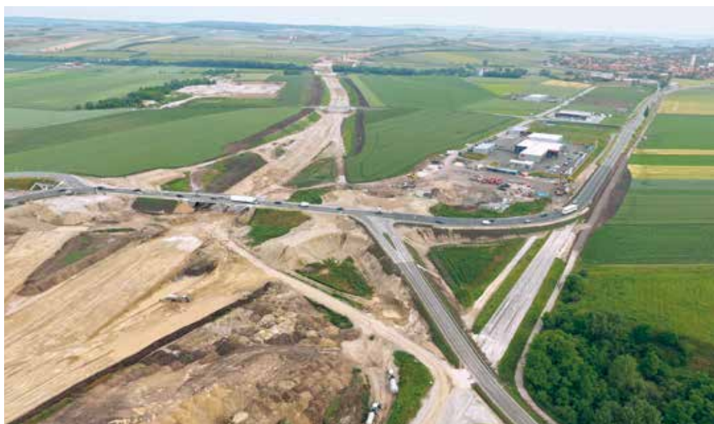
Előtte/utána: az Ú17 jelű hid az 1. építési szakaszban az építés közben és készen. Mindkét körforgalmat betonburkolattal készítették. (Nagy kép jobbra, túloldalt)
