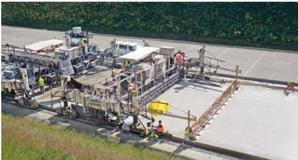
A betonburkolat beépítése
