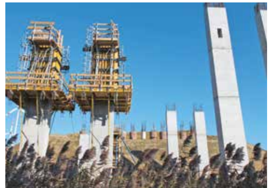
A négyszög keresztmetszetű ikerpillérek építése
