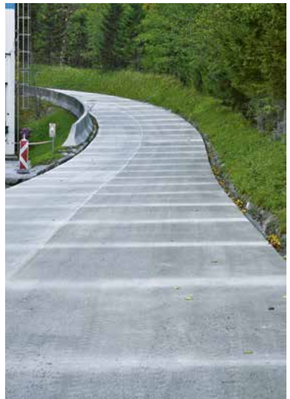
19. ábra: Kézi betonozás az ívek kiszélesítése mentén
