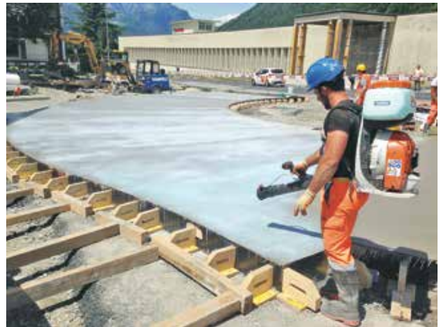
5. A kombinált felületkezelő szer (késleltető és párazáró) felpermetezése
