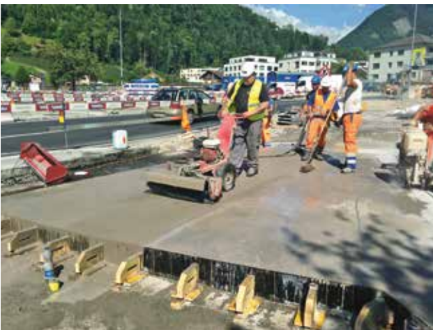
7. A betonfelület kikéféltése és a párazáró szer ismételt felszórása
