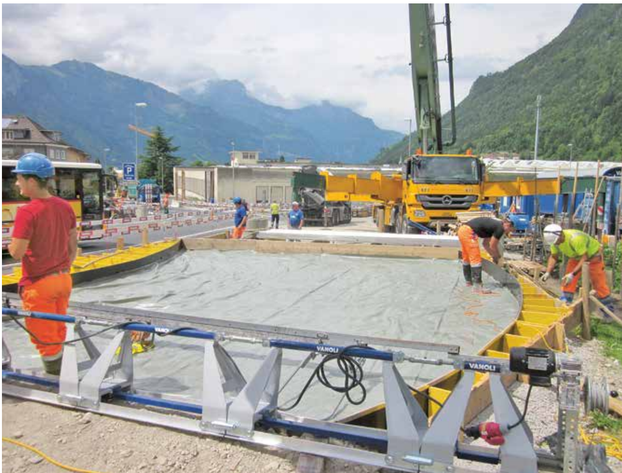
A 2. próbaszakasz építése
