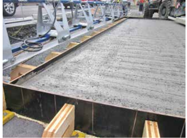
2. A friss (alsó) betonréteg feldurvítása
