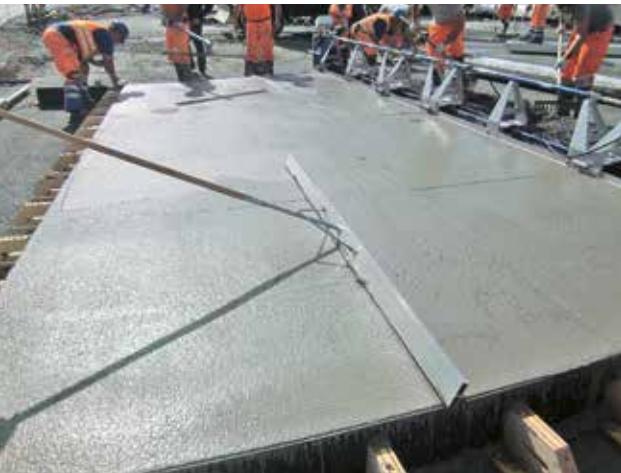
4. Lehúzás és a hullámosság ellenőrzése
