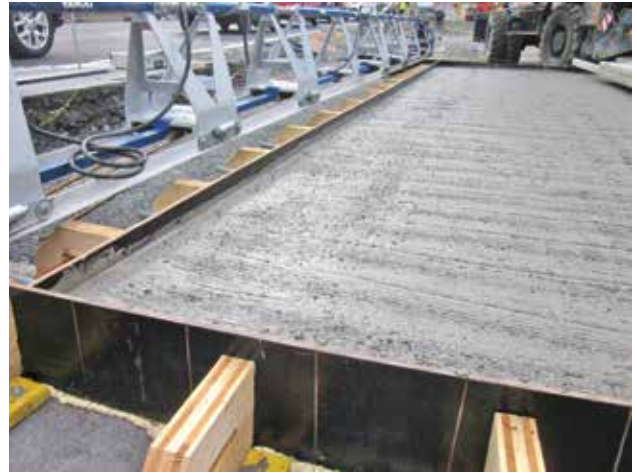
2. A friss (alsó) betonréteg feldurvítása
