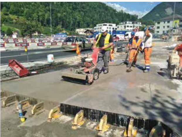
7. A betonfelület kikéfélese és a párazáró szer ismételt felszórása
