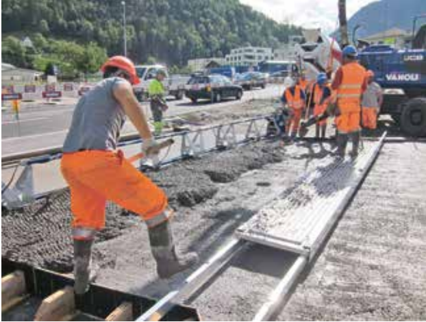
3. A 6 cm vastag felső betonréteg beépítése
