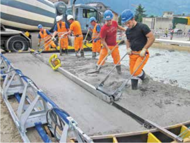
1. A 20 cm vastag alsó betonréteg beépítése
