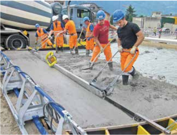
1. A 20 cm vastag alsó betonréteg beépítése
