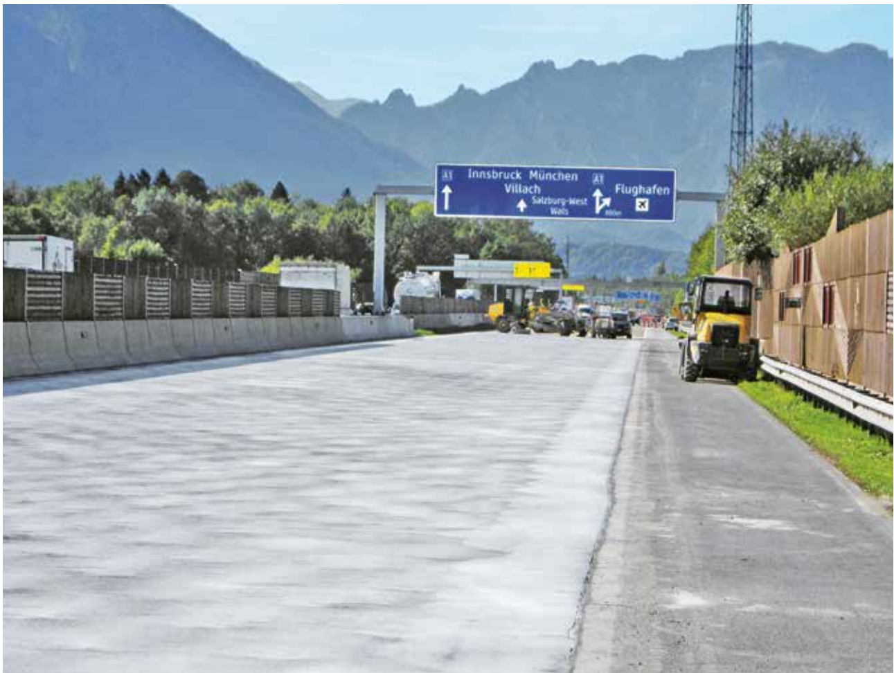
9. ábra: Kész, felújított betonlemez
