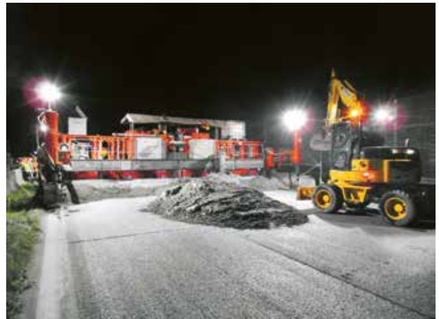
8. ábra: Betonpályalemez beépítése éjszaka
