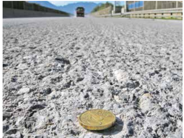
5. ábra: Régi betonfelület a nagy nyomású vízszugaras (HDW) tisztítás után
