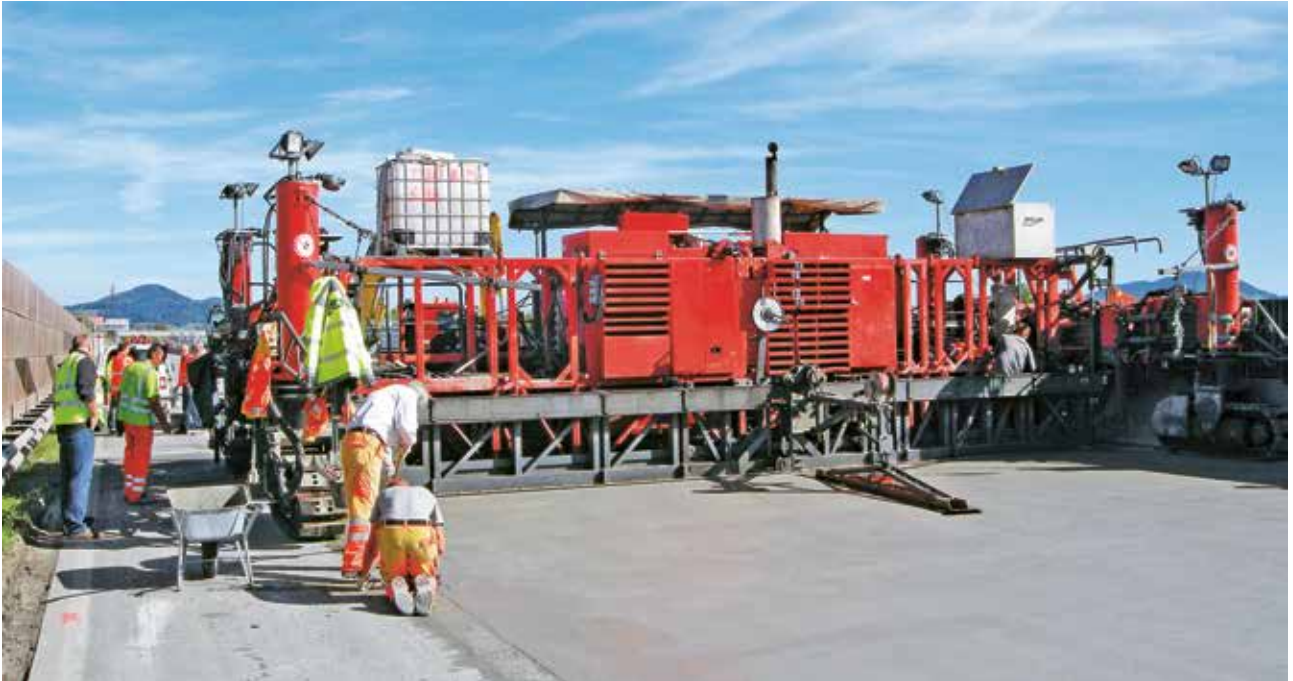
7. ábra: Betonpályalemez beépítése nappal
