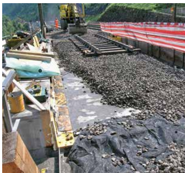
3. kép: Ágyazati zúzalék és szerelt vágány beépítése az UNT szálbeton szigetelésre. A kép baloldalán: zsaluzat a terelőfal függőleges UNT szálbeton bevonatolásához
