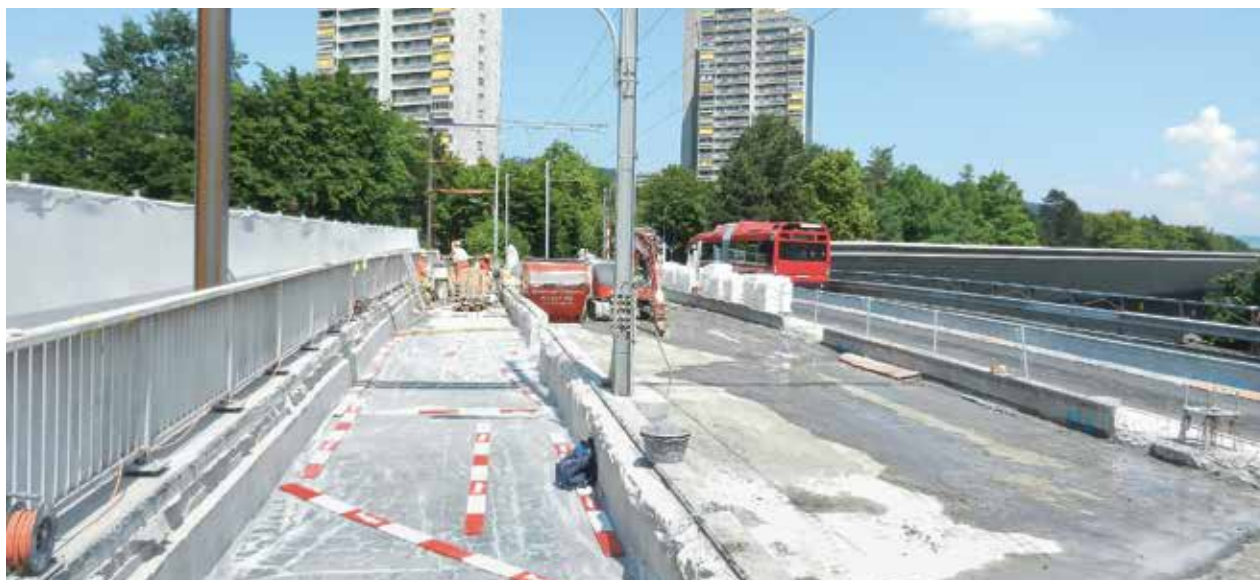
12. kép: A bevonatoláshoz előkészített félszélességű pálya képe
