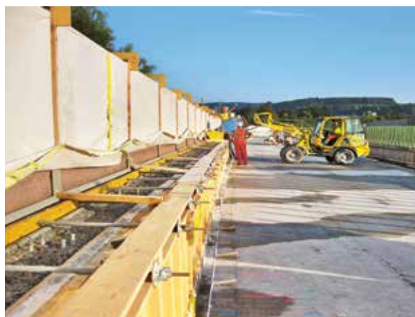
4. kép: A bevonatoláshoz előkészített zsaluzat
