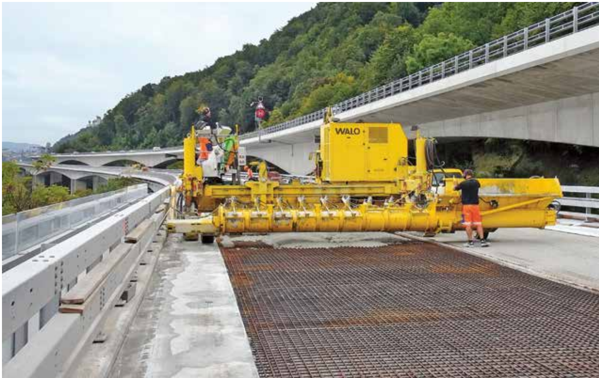
14. kép: Az UNT szálbeton gépesített beépítése egy e célra átalakított finiserrel
