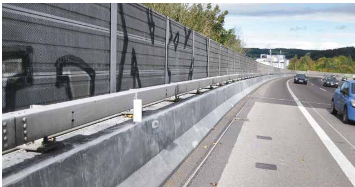
5. kép: Az UNT szálbetonnal bevont kész terelőfal
