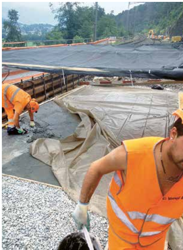
2. kép: Az UNT szálbeton letakarása közvetlenül a beépítés után napfényvédő tetővel
