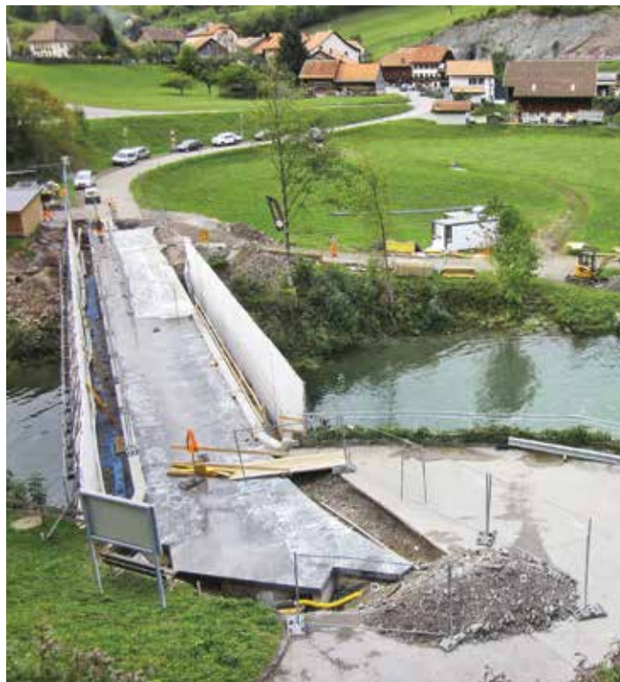
8. kép: Kilátás a montbovoni hídra a felújítás közben
