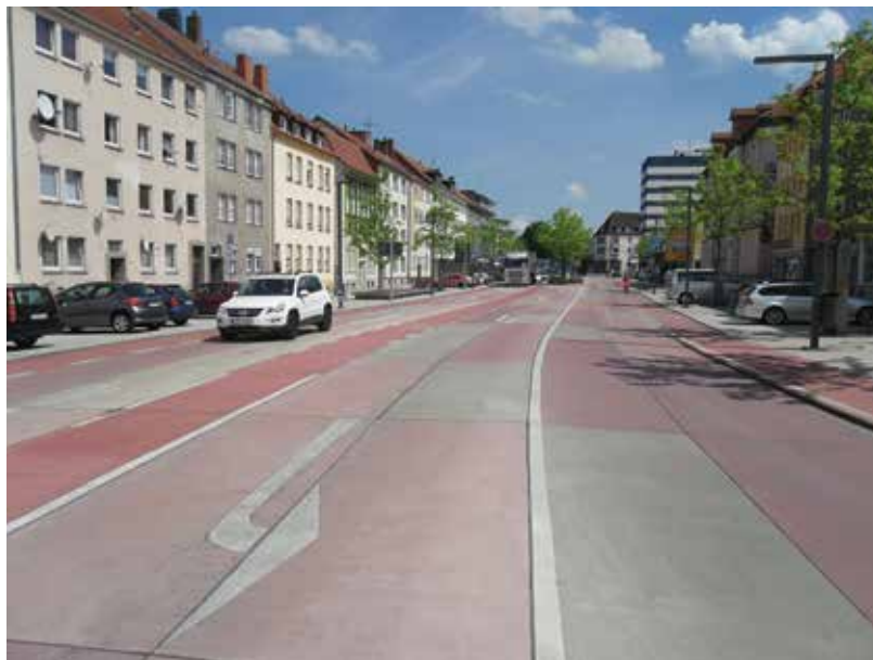
14. ábra: Az anyagában színezett beton teszi lehetővé, hogy a színhatás a közlekedési terhelés ellenére megmaradjon
