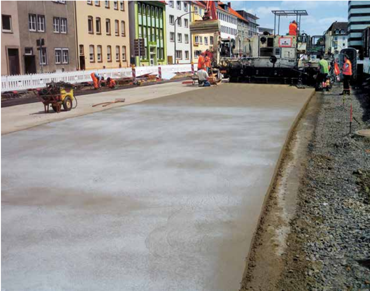
6. ábra: Az alsó pályabeton réteg készítése
