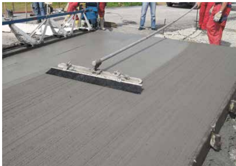
8. ábra: A „seprűzéssel” kialakított textúra (illusztráció)
