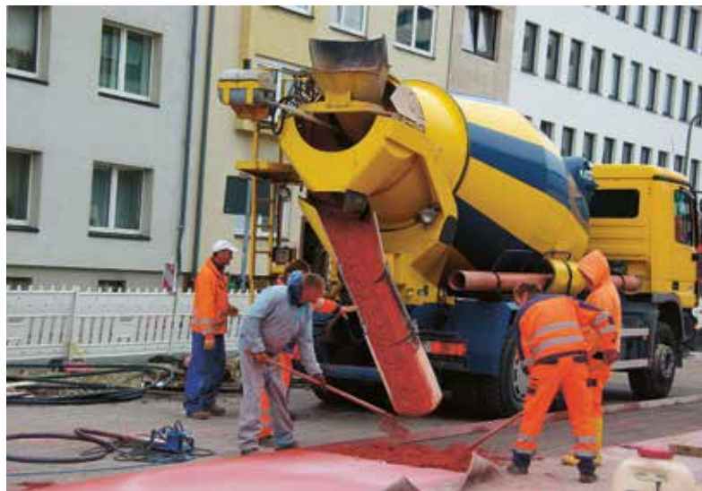
7. ábra: A színes felső pályabeton réteg készítése
