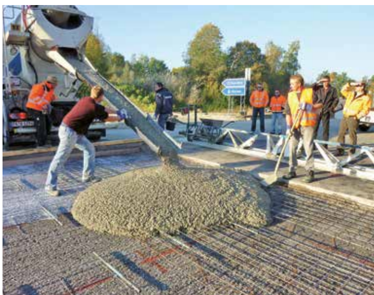
Kézi beépítés vibrogerendával
