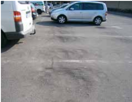
Elynomódások, pontszerű benyomódások
