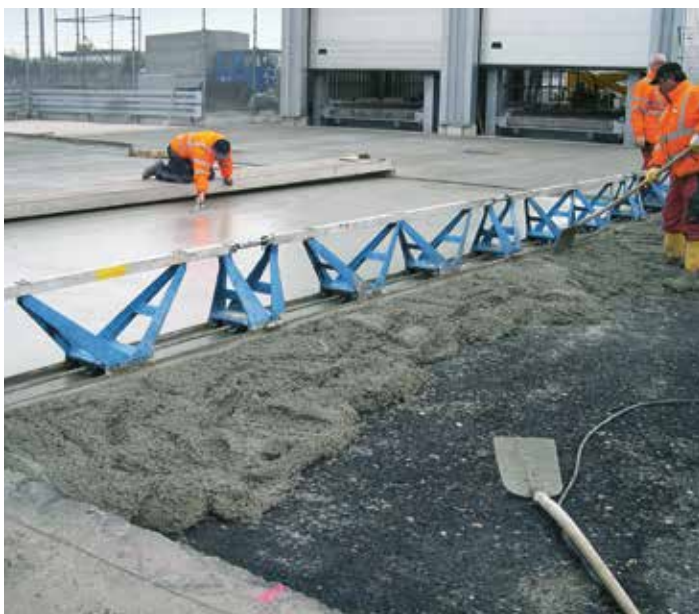
Betonbeépítés vibrogerendával
