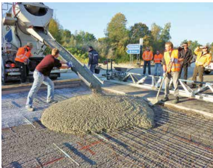
Kézi beépítés vibrogerendával
