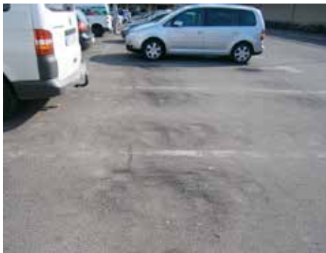
Elynomódások, pontszerű benyomódások
