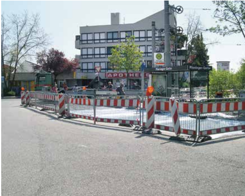
Az építési terület biztosítása védőkorláttal
