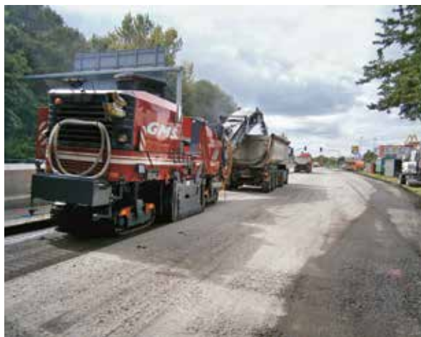
Az aszfalt marása
