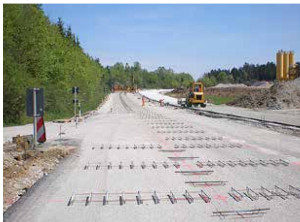
Lerakott tűskézés és horgonyvasak előkészített aljazaton
