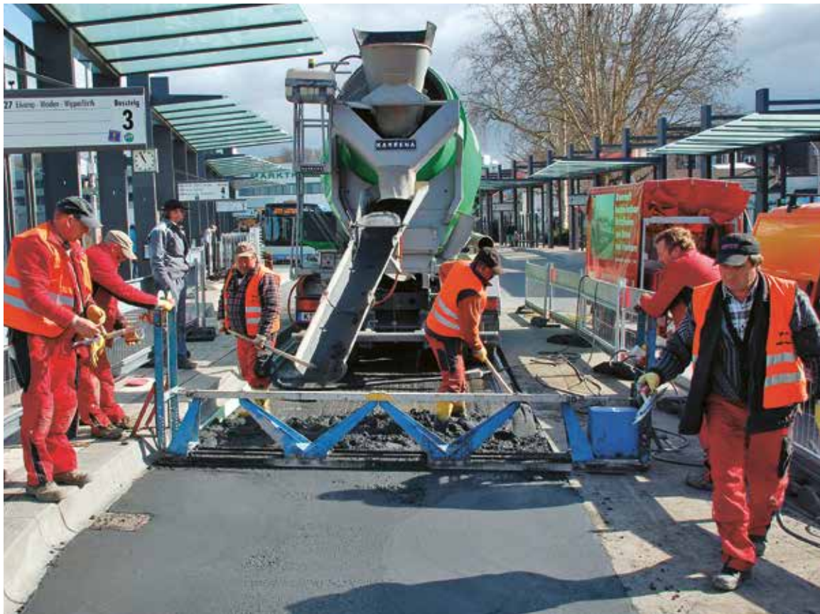
Kézi beépítés merülővibrátorokkal és vibrogerendával
