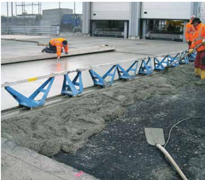
Betonbeépítés vibrogerendával
