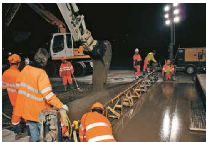
A gyorsbeton beépítése (2,5 órás korai szilárdság: 20 N/mm 2 )
