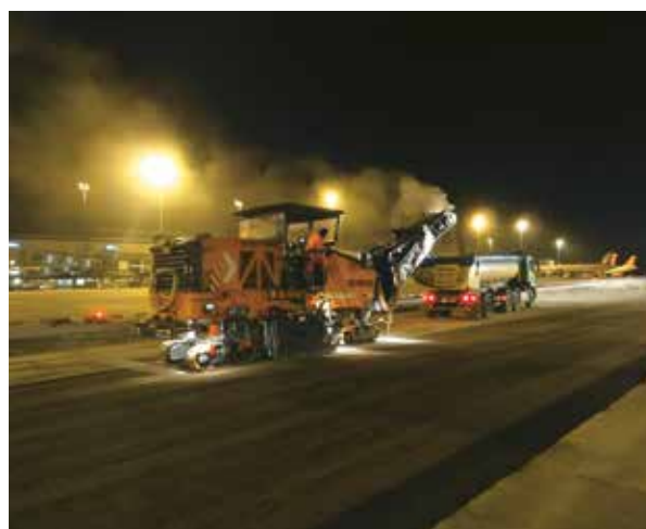
A cementstabilizációs alsó réteg bemarása
