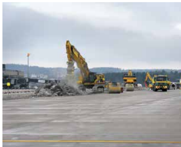
A meglévő betonburkolat feltörése
