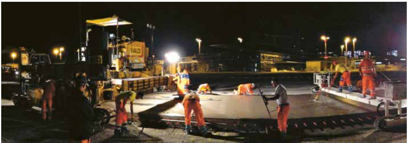
Gépi betonbedolgozás csúszózsálús finiszerrel
