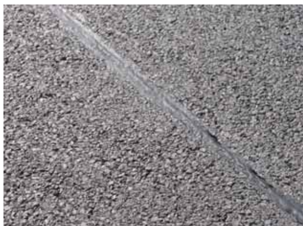
4. ábra: Zajcsökkentett, csak 1 cm vastag aszfalt-fedőréteg, kiöntött hézagokkal (Fotó: Kampen, Rolf)
