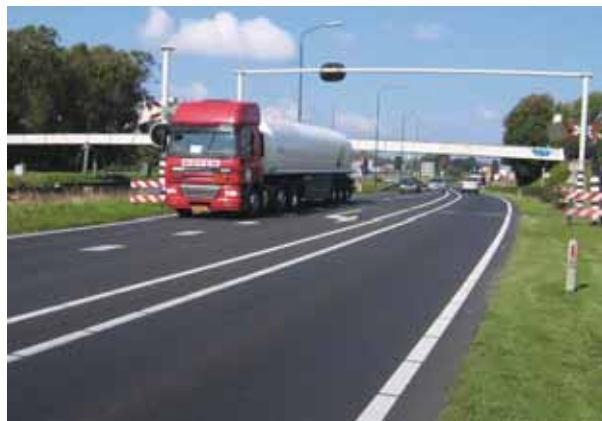
3. ábra: Vékony aszfaltréteg beton pályalemezen Hollandiában (Fotó: Kampen, Rolf)
