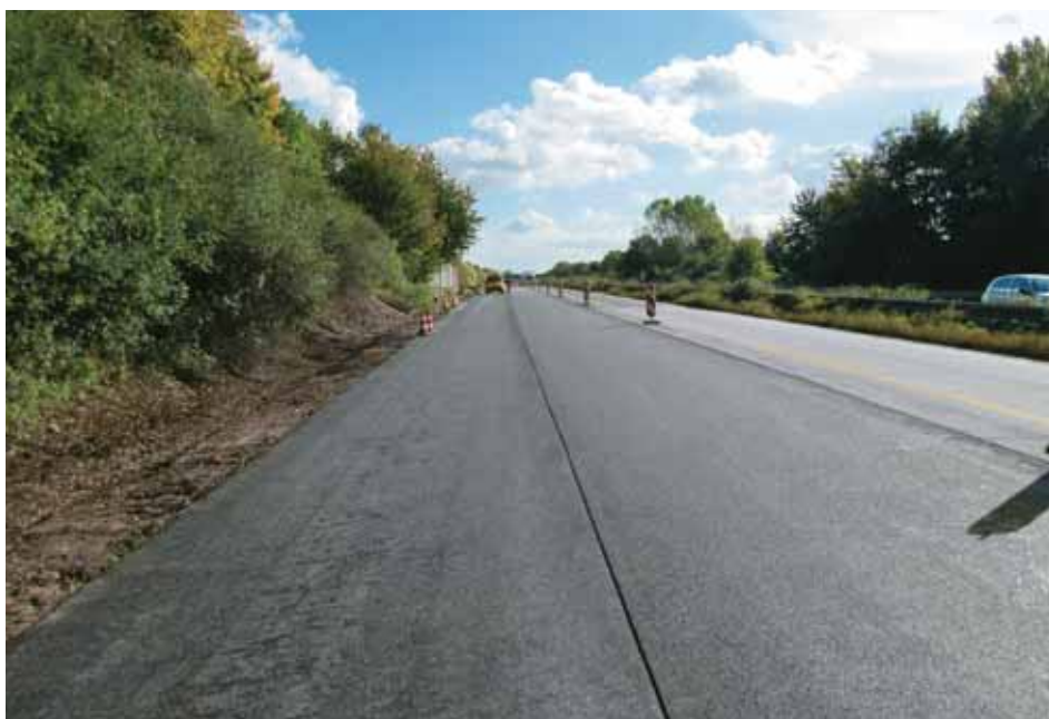
1. ábra: Kis zajkibocsátású vékony aszfaltréteges betonpálya az A61 autópályán (Fotó: Kampen, Rolf)
