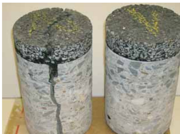
5. ábra: „Vékony aszfaltréteg betonon” - magminták (Fotó: Straßen. NRW)
