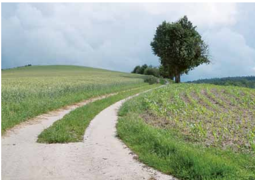
5. ábra: Kész, füvesített betonnyomsávós út „Dallinger”, Felső-Ausztria (Fotó VÖZ)
