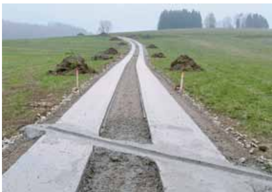
4. ábra: Keresztirányú vízlevezető folyóka (Fotó: Haslehner, Burgenlandi Tartományi Kormányzati Hivatal)
