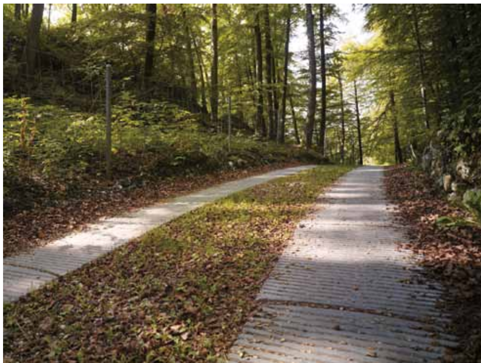
6. ábra: Nyomsávelemek a Bielersee melletti Schernelz-ben (Fotó: Creabeton Matériaux AG, Lyss)
