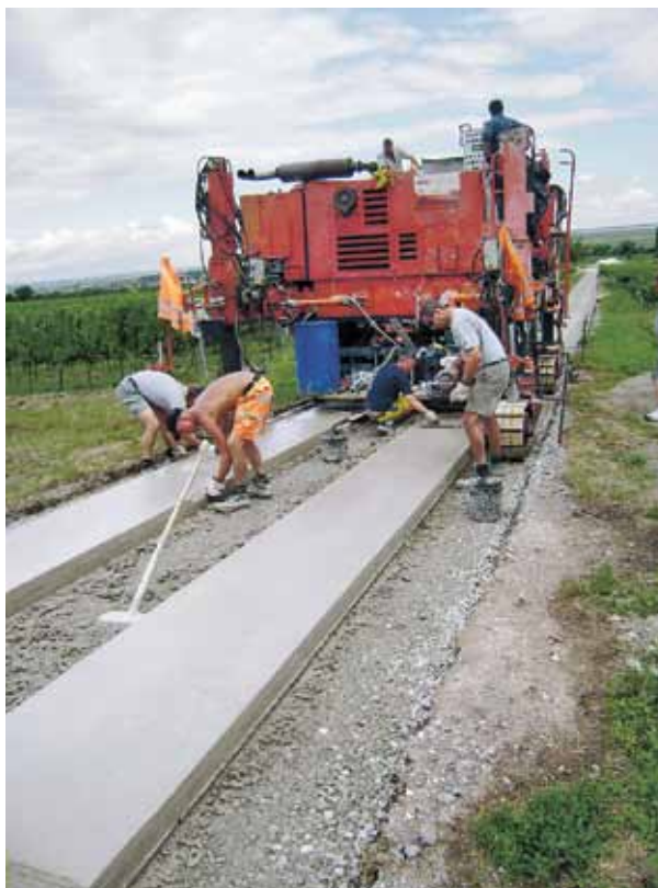
1. ábra: Beépítés finiserrel. Beton-nyomsávós út Ruszt és Oka (Rust/Oggan) közt, Burgenlandban (Fotó VÖZ)
