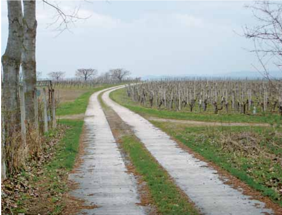
2. ábra: Beton-nyomsávós út Haracsony (Horitschon) mellett, Burgenlandban (Fotó VÖZ)
