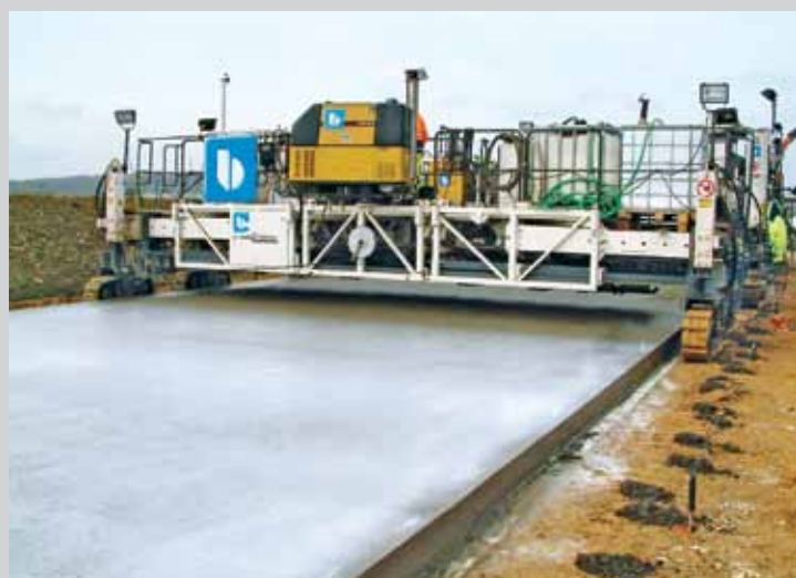
6. kép: Az utókezelő párazáró szer felszórása
