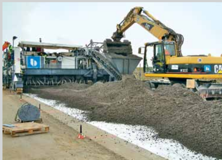
4. kép: Az aljzatra kerülő pályabeton alsó rétege
