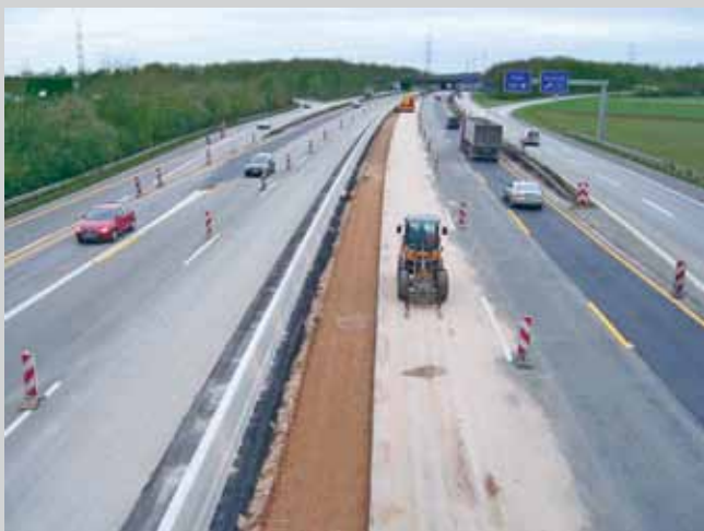
7. kép: Szabadon fektetett beton védőfal építése
