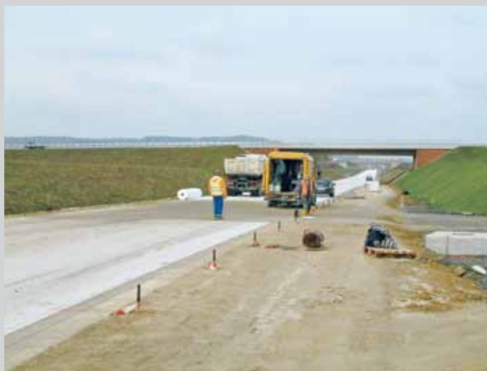
2. kép: A hidraulikus kötésű aljzatbetonra (HGT) terített geotextília
