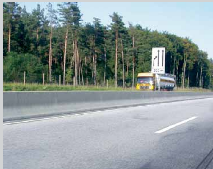
6. kép: Beton védőfal New Jersey elemekből
