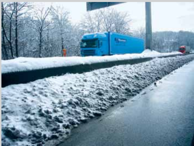
12. kép: Hófödte beton védőfal a középső sávban az A 46-os autópályán
