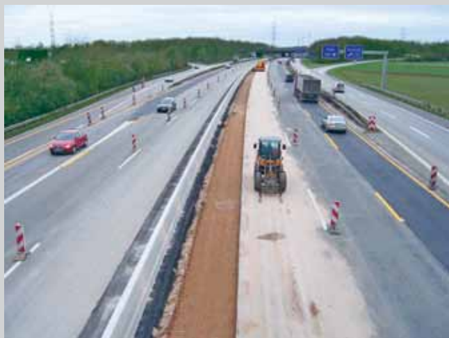
7. kép: Szabadon fektetett beton védőfal építése
