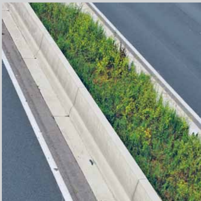
5. kép: Beton védőfal Step-Profilokból
