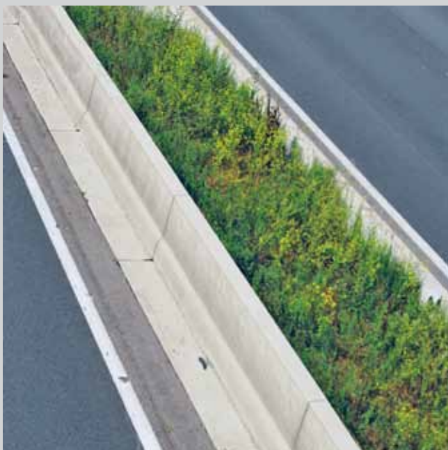
5. kép: Beton védőfal Step-Profilokból
