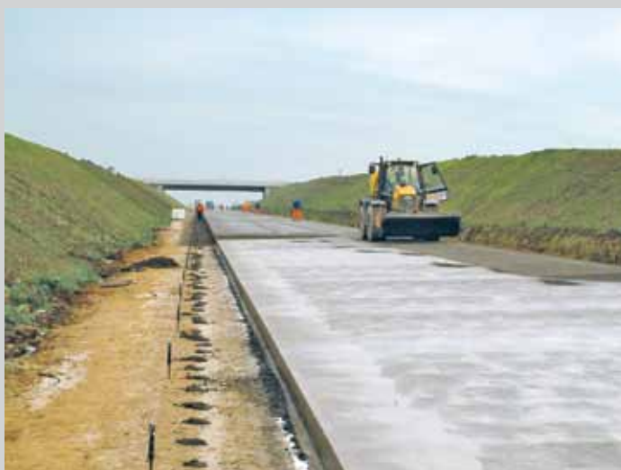
5. kép: A mosott betonfelületet készítő lekefélés
