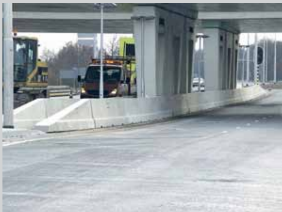
10. kép: Beton védőfal hídpillérek mentén
