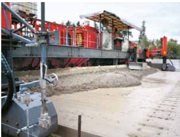
6. ábra: A beton (felső réteg) beépítése csúszózsálas finiszerrel
