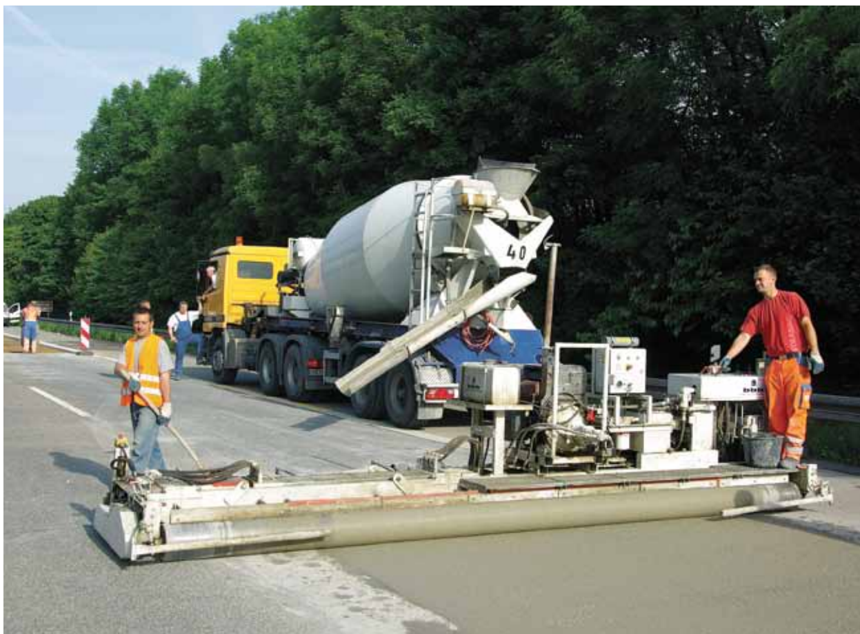
2. ábra Építésjellelű fenntartási munka betonpályán: lemezcseré
