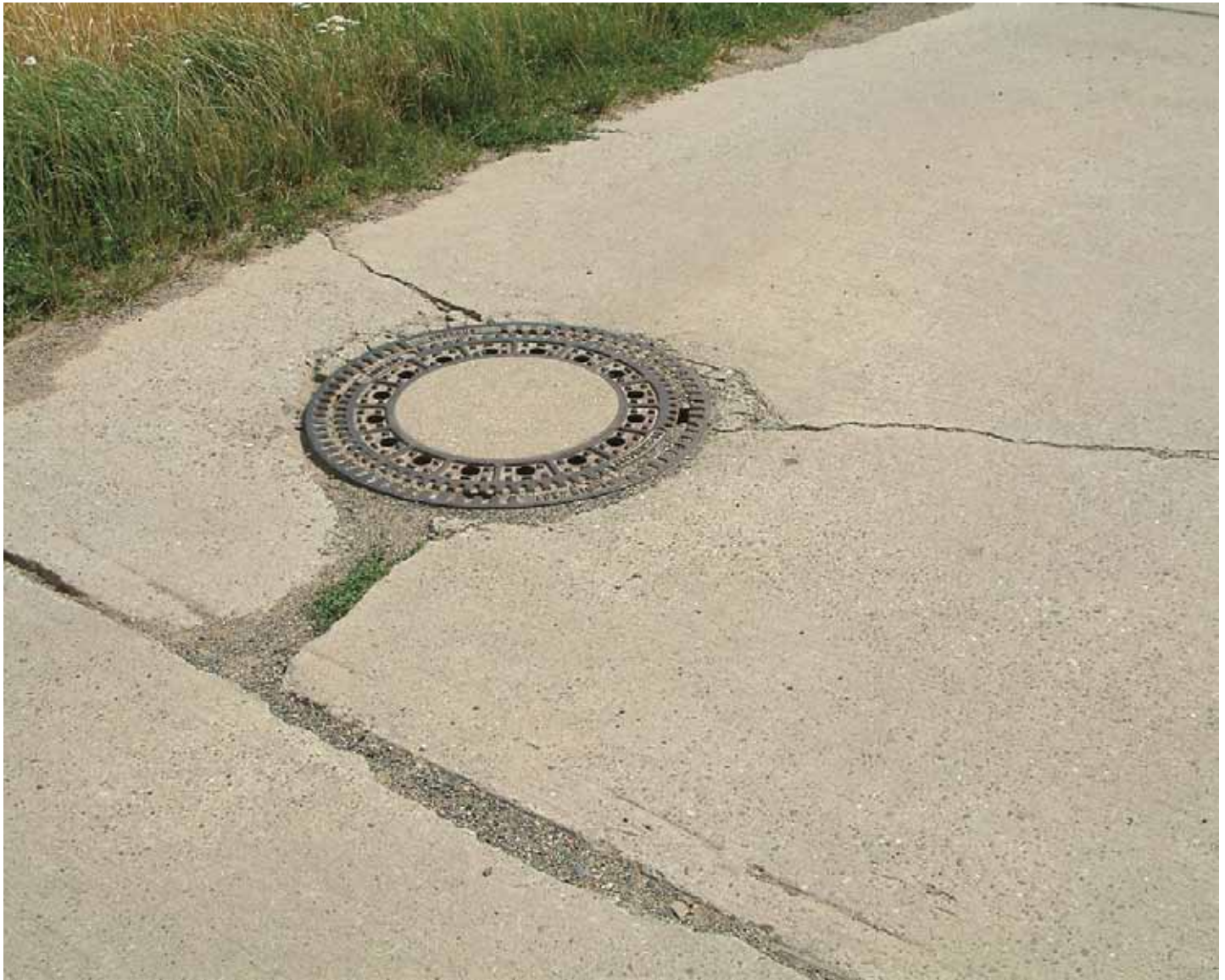
12 A célszerűtlenül helyzetű keresztthézagok miatt repedések egy vízakna körül
