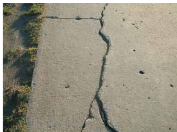
6 Repedés egy lemezszélen lerogyással, ék alakú zárvánnyal
