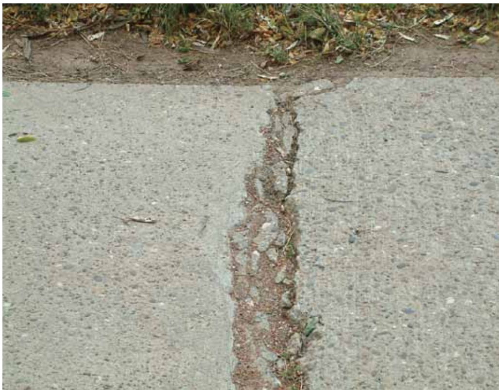
4 Éltörés a hézag elégtelen tömörítése miatt
