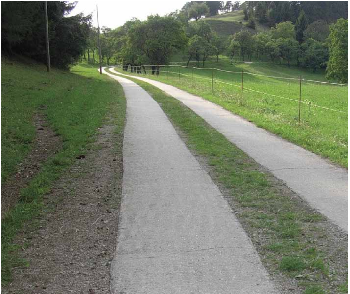
13 Jó állapotban megtartott betonút
