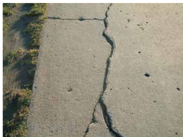
6 Repedés egy lemezszálon lerogyással, ék alakú zárvánnyal
