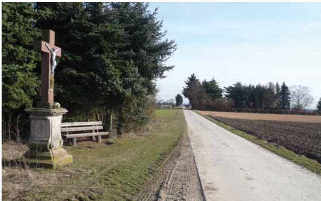
2 50 évesnél idősebb betonút
