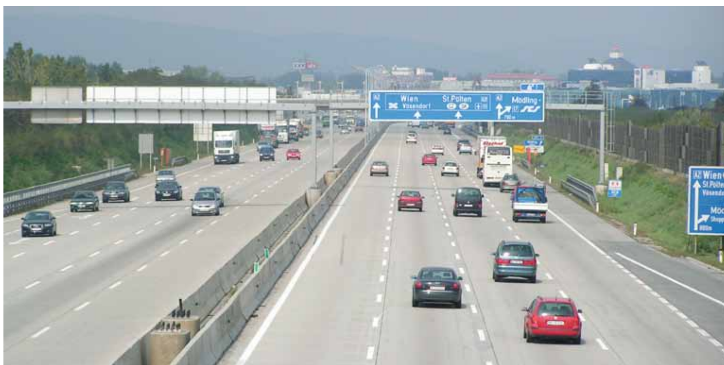
1. kép: A Vösendorf-i csomópont teljes felújítása és szélesítése – A2 déli autópálya, 2005 Fotó: VÖZ
