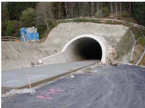
4. kép: Betonburkolat a déli A2 autópályán a Herzogberg-alagútnál Fotó: VÖZ
