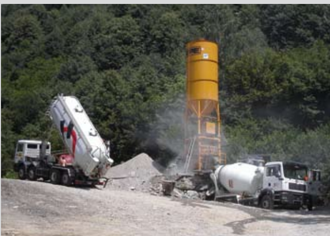
Felvonulási épületek és mobil betonkeverő, anyagtároló
