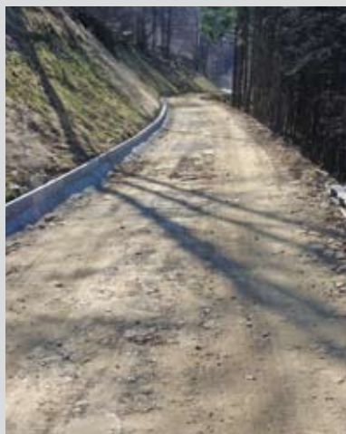
Kész durva földmútükör (betonozásra kész)
