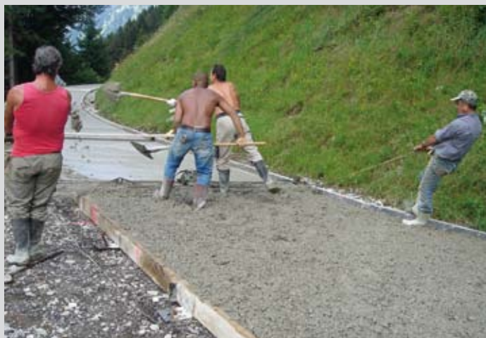
Betonbeépítés: lehúzás vibrogerendával
