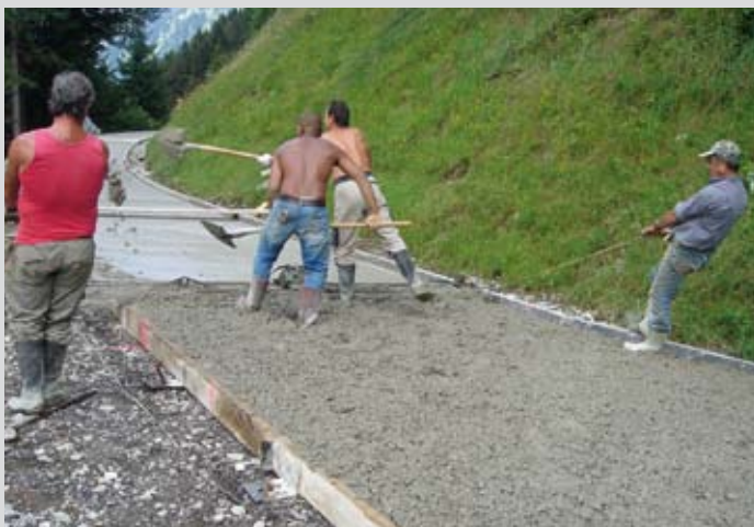
Betonbeépítés: lehúzás vibrogerendával
