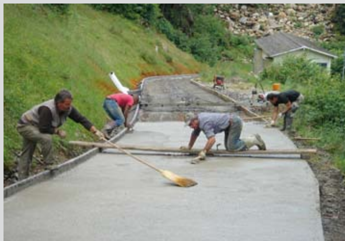
Utómunkálatok: felületkezelés (simítás fa simítólapplal) és seprűzés
