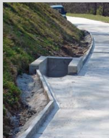
Beömlő aknák a keletkező felszíni vizek elvezetésére
