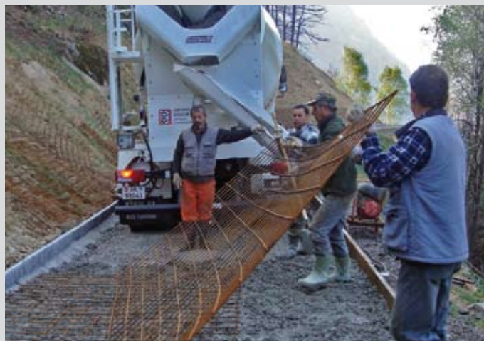
Betonacél háló fektetése
