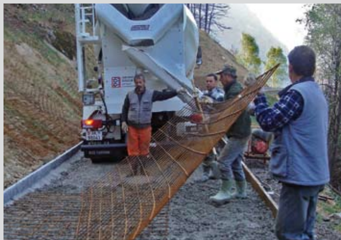
Betonacél háló fektetése
