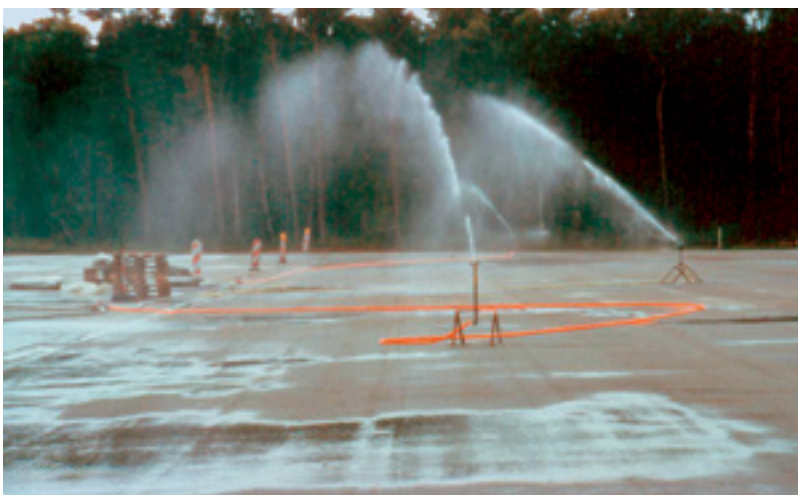
6. ábra Utókezelés szektoronkénti esőztetővel [1]
