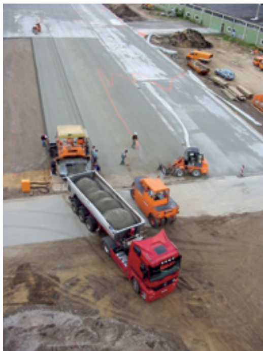
3. ábra Hengerelt beton beépítése sávokban [1]
