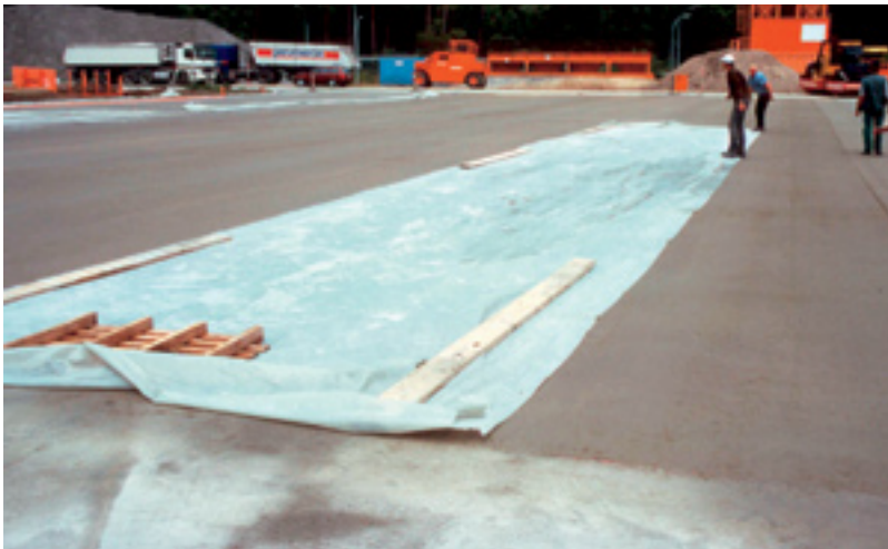
5. ábra Fóliával történő takarás eső veszélye esetén [1]
