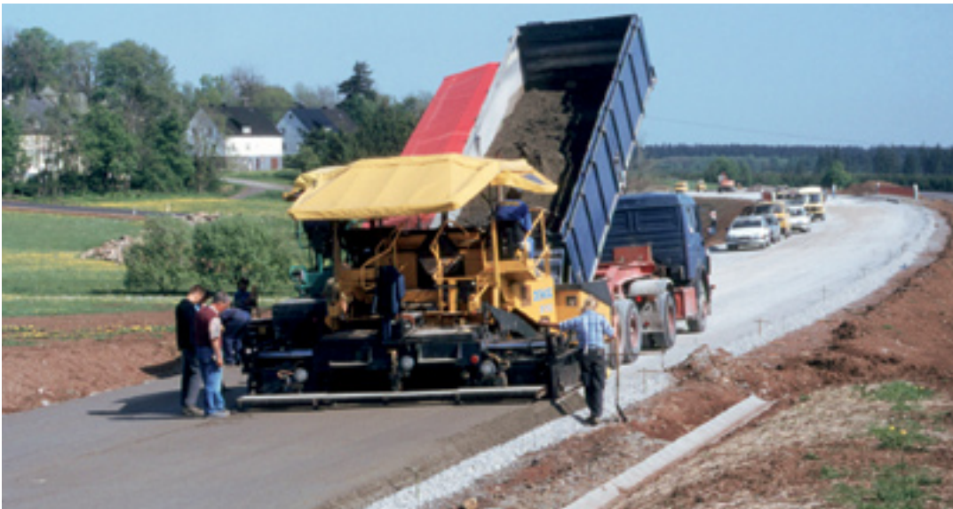
7. ábra Kísérleti szakasz „hengerelt beton mint alapréteg, vékony aszfaltburkolattal” a B 54 úton a Westerwald-ban
