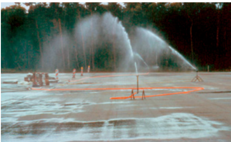
6. ábra Utókezelés szektoronkénti esőztetővel [1]
