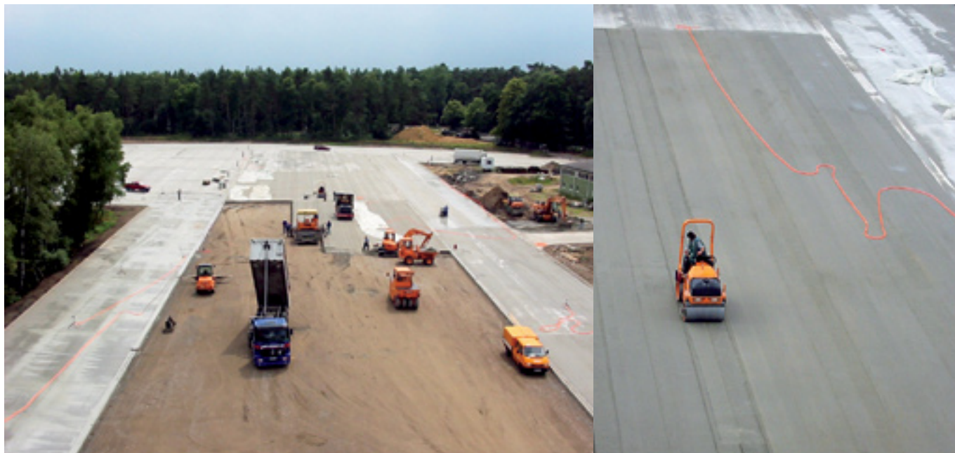
1. ábra Hengerelt beton beépítése a hesedorfi anyagtárolóban [1]
