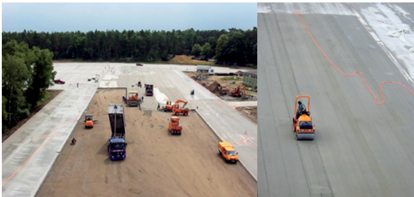
1. ábra Hengerelt beton beépítése a hesedorfi anyagtárolóban [1]
