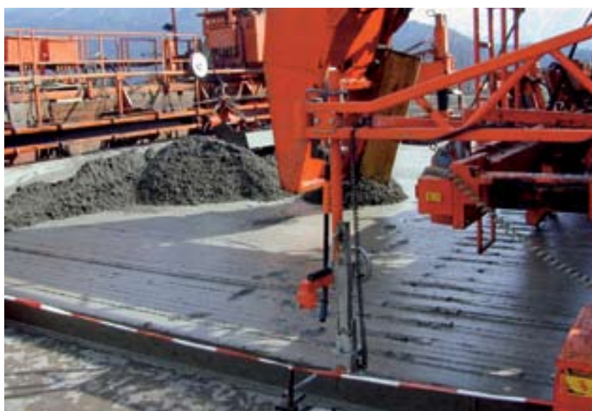
A1 – Mondsee – Betonburkolat építése
