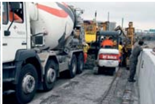
2 A beton szállítása keverőtartályos gépkocsival történik. A betont egy kis rakodógép teríti el.
