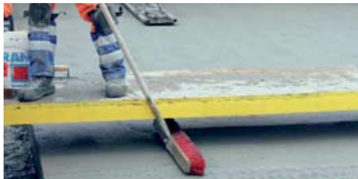
4 A még lágy betont seprővel keresztirányban bordázzák azért, hogy a burkolat érdességét növeljék.
