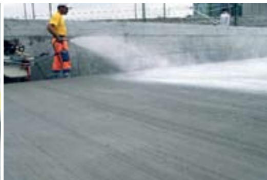
5 Kár minden fáradságért, ha a beton utókezelésére nem fordítanak kellő figyelmet. A párazáró kipermetezése megvédi a betont az idő előtti kiszáradástól.
