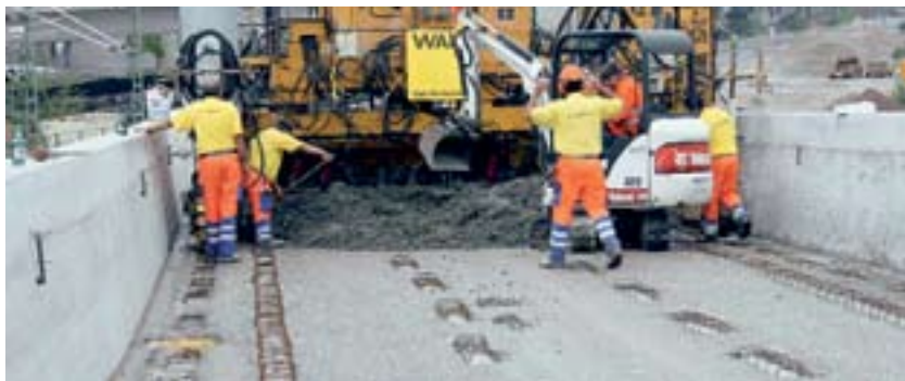
1 A szerkezeti és pályabeton közötti optimális kapcsolatot a vasalás biztosítja.
