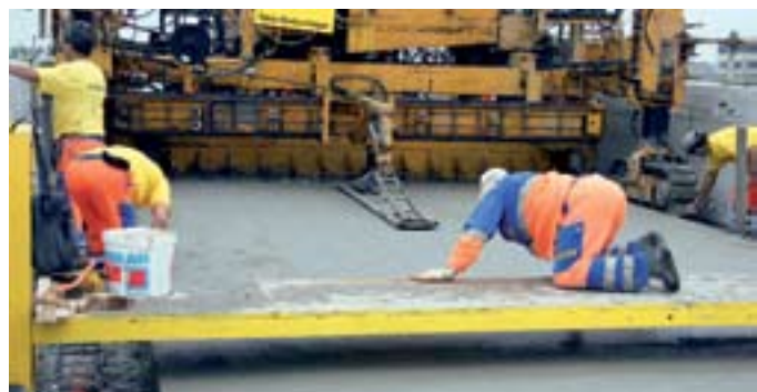
3 A lengő hosszsimító elegyengeti a felületet; a vakolókanállal az utolsó egyenetlenségeket simítják el.
