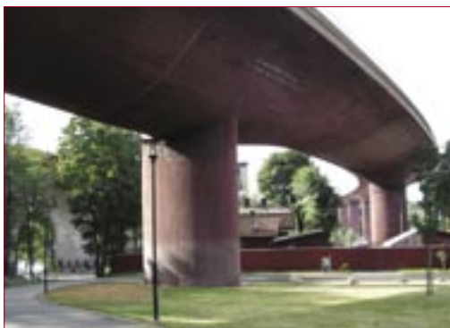
Megtévesztő és csalóka a karcsúság. Két vasútpálya van a híd testébe süllyesztve
